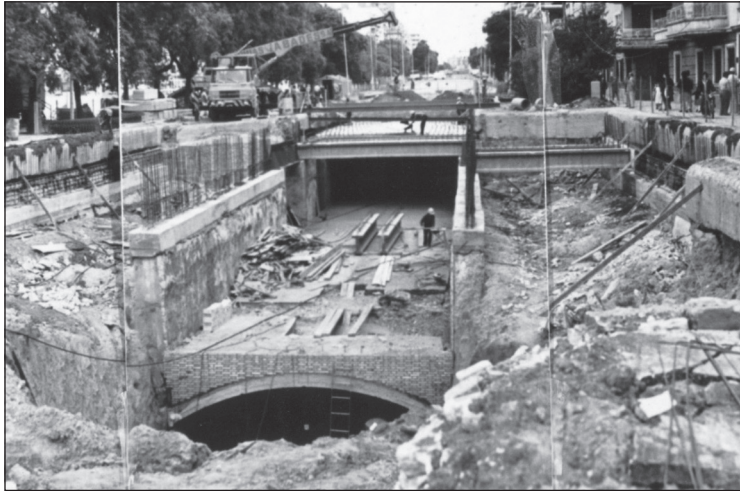
FIGURA 6 CONSTRUCCIÓN DEL METRO MEDIANTE LA TÉCNICA DE LAS PANTALLAS DE HORMIGÓN ARMADO
