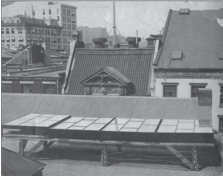
FIGURA 1 PRIMERA INSTALACIÓN FOTOVOLTAICA EN UNA CUBIERTA DE NUEVA YORK, REALIZADA EN 1884 POR C. FRITTS (PERLIN, 2013)
