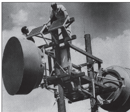
FIGURA 6 INSTALACIÓN FV EN UN REPETIDOR DE MICROONDAS EN ARIZONA, 1976 (PERLIN, 2013)
