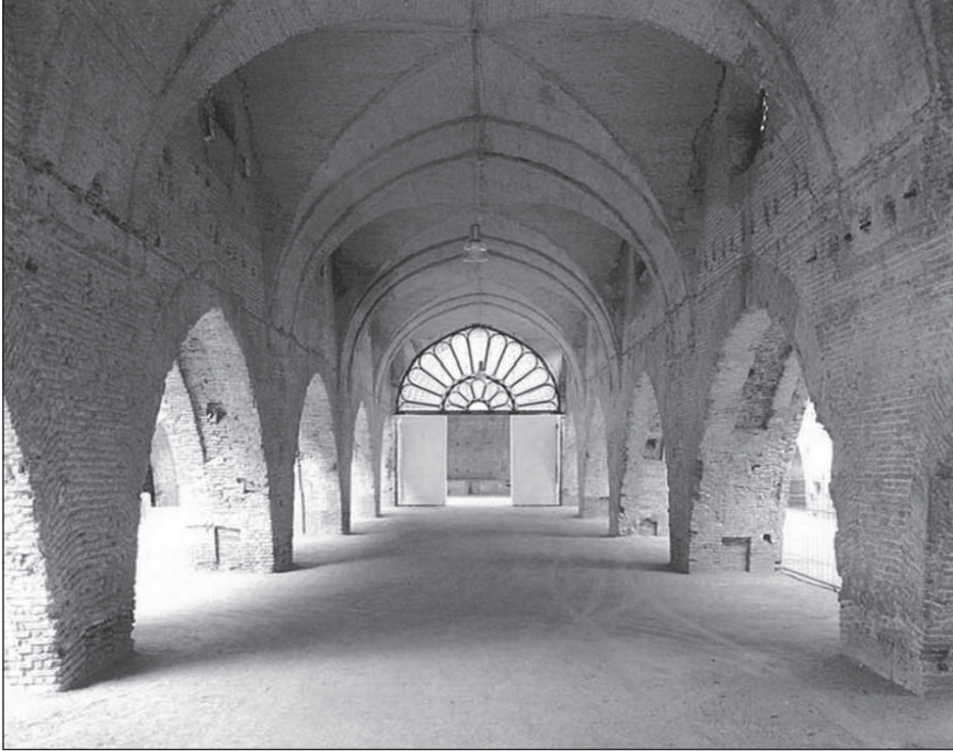
FIGURA 6 SITUACIÓN ACTUAL DE LA NAVE 4 (BARRIONUEVO Y MOLINO, 1999)
