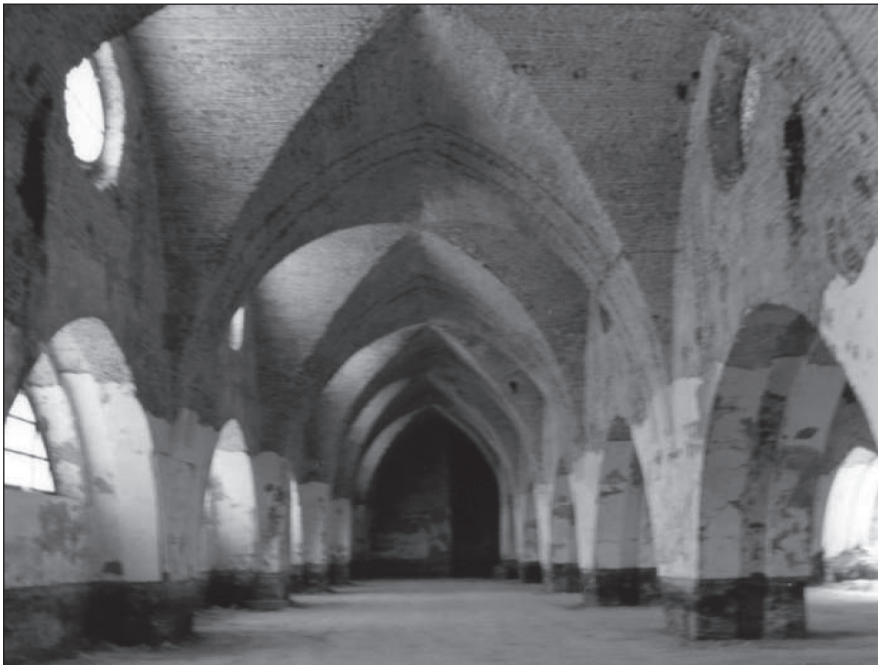
FIGURA 5 VISTA INTERIOR DE LA NAVE 1
