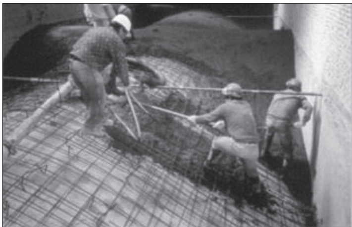
FIGURA 14 CONSOLIDACIÓN DE BÓVEDAS (MOLINO, 2015)
