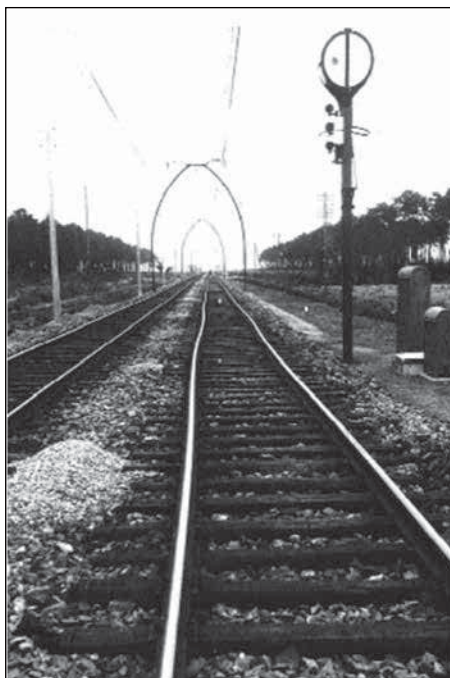
FIGURA 8 ESTADO DE LA VÍA DESPUÉS DEL RECORD DE VELOCIDAD DE 330 KM/H EN 1955 [10]
